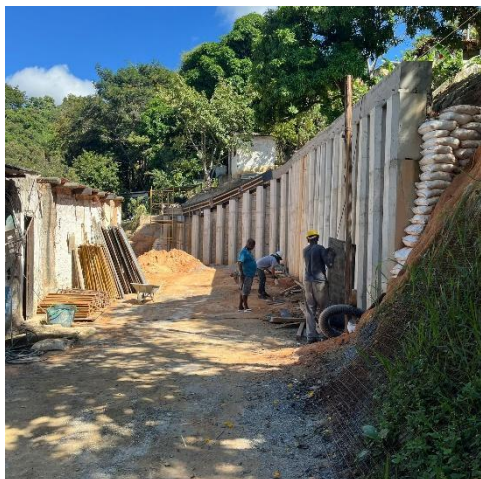
Legenda: Muro de contenção. Autoria: Eduardo Santos Data: 03/04/2025
